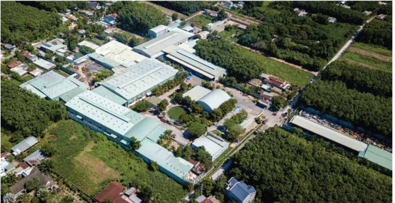
TOÀN CẢNH NHÀ MÁY SẢN XUẤT
