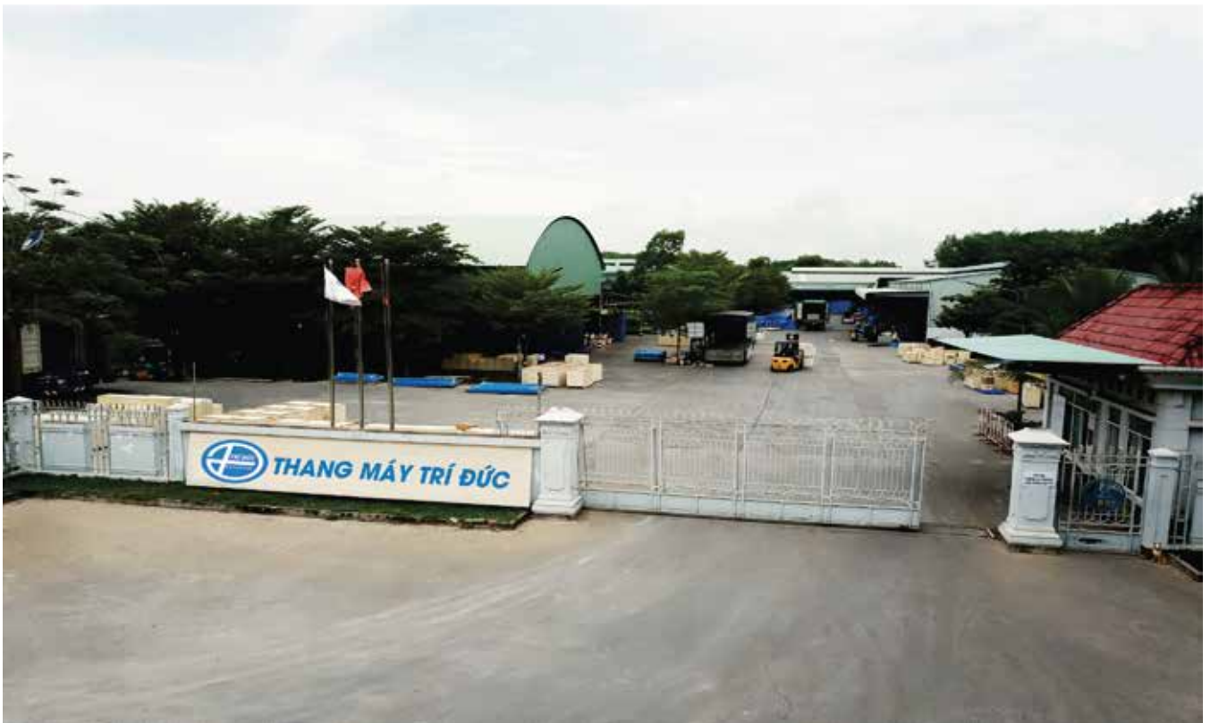
TOÀN CẢNH NHÀ MÁY SẢN XUẤT
